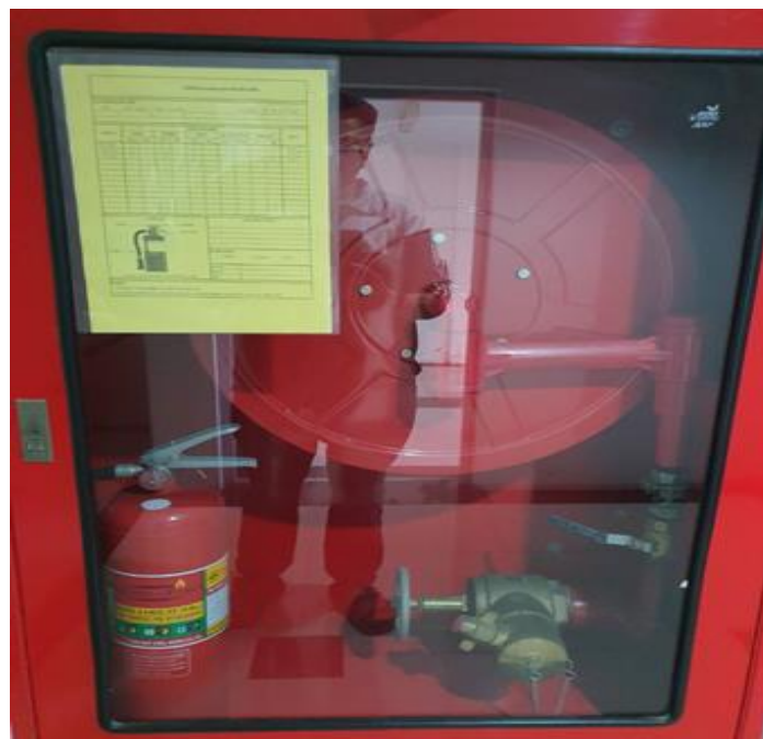
ตู้เก็บสายฉีดน้ำดับเพลิงพร้อมอุปกรณ์ (FHC) และถังดับเพลิงเคมี
