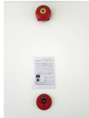
กริ่งสัญญาณเตือน
