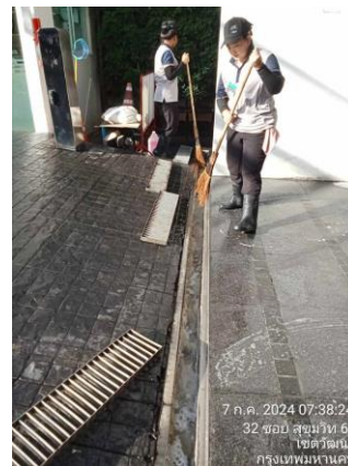
รูปที่ 2-34 การทำความสะอาดตะแกรงของบ่อดักขยะ
