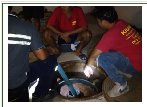
รูปที่ 2-13 การสูบล้างถัง
