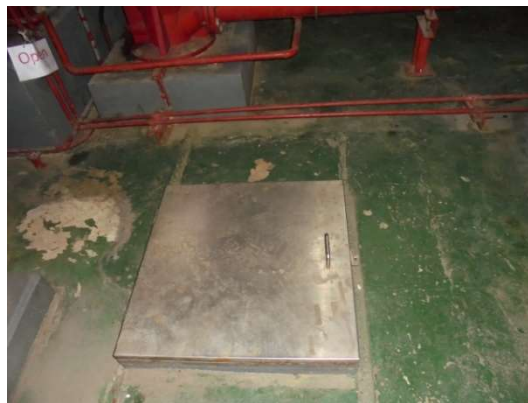
ภาพที่ 4-24 สภาพฝาดังสำรอน้ำใต้ดิน ปิดมิดชิดและมีขอบยกสูงจากพื้น
