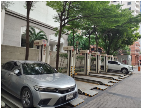
ภาพที่ 4-7 ที่จอดรถแบบ 2 Layer Lifting-Sliding Type ติดตั้งไว้ที่ทิศตะวันตกและทิศตะวันออกของโครงการ
