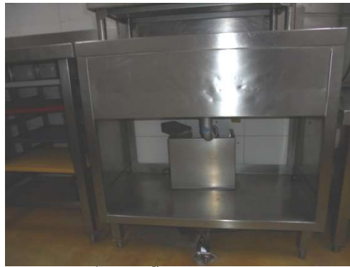
ภาพที่ 4-4 ติดตั้งถังดับไข่มุนในห้องครัว
