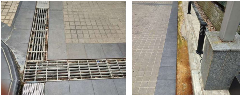
ภาพที่ 4-23 ลอกท่อระบายน้ำ มีตะกอนตกสะสม ปัจจุบันสามารถระบายน้ำได้เป็นอย่างดี รางระบายน้ำอยู่ในสภาพดีสะอาด
