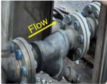
รูปที่ 1 Y-strainer แบบเหล็กหล่อ ติดตั้งอย่างไม่ถูกต้องในท่อสแตน เลสแบบเชื่อม
