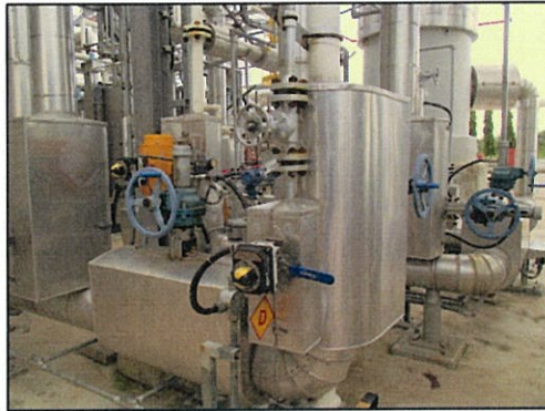
ภาพที่ 2.2-27 ระบบแฉ่งเตียนเมื่อพบความผิดปกติของอุณหภูมิภายในถังที่ทำการฟื้นฟูสภาพสารดูดซับ
