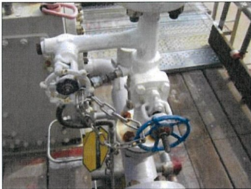
ภาพที่ 2.2-23 ระบบวาล์วแบบ Double block and bleed
