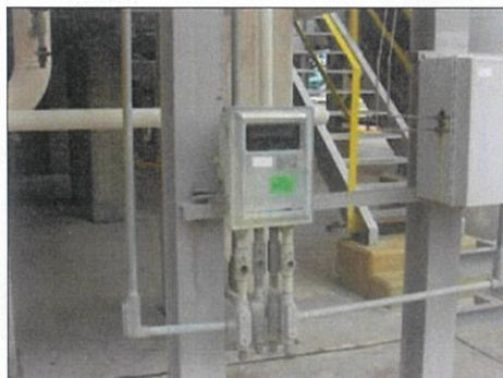
ภาพที่ 2.2-2 On-line O 2 Analyzer ของปล่อง Furnace
