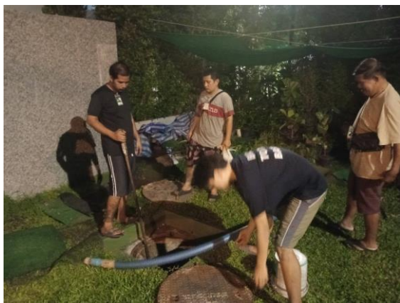
รูปที่ 2-11 การสูบน้ำจากตะกอน และตักกากไขมัน
