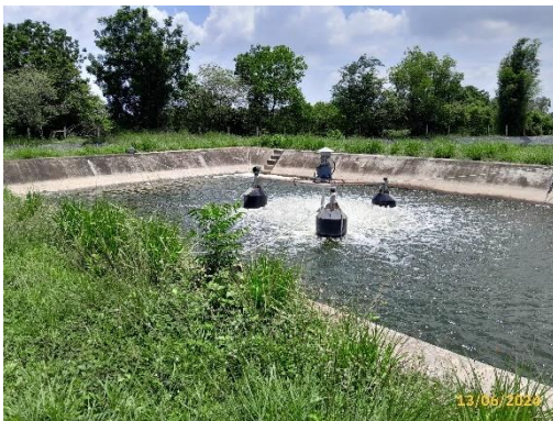
บ่อเติมอากาศ (Aerated Lagoon)
