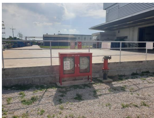
ภาพที่ 2.2-23 ตัวอย่างอุปกรณ์ป้องกันเหตุเพลิงไหม้สำหรับการเก็บก๊าซ LPG
