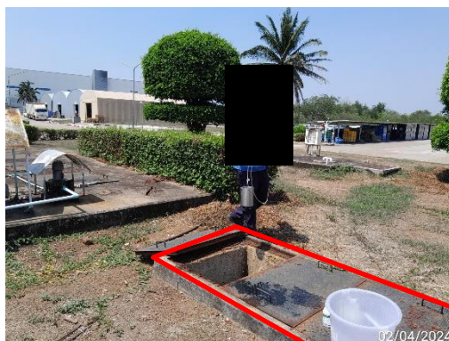
ภาพที่ 2.2-5 บ่อตรวจสอบลักษณะน้ำเสียก่อนระบายน้ำเสียเข้าสู่ระบบบำบัดน้ำเสียส่วนกลาง
