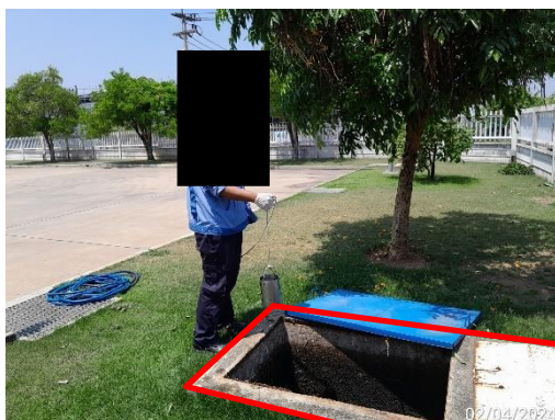
ภาพที่ 2.2-5 บ่อตรวจสอบลักษณะน้ำเสียก่อนระบายน้ำเสียเข้าสู่ระบบบำบัดน้ำเสียส่วนกลาง
