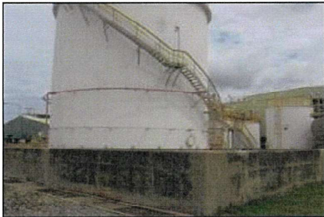
ภาพที่ 2.2-19 ถังเก็บสารเคมี และคันคอนกรีตรองรับภาวะการรั่วไหล
