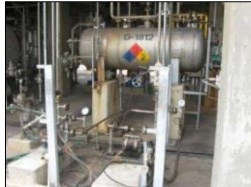
ภาพที่ 2.2-6 ระบบแยกน้ำมันออกจากน้ำ
