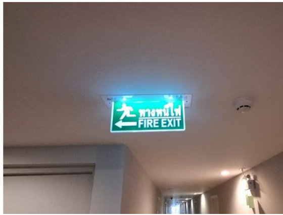
รูปที่ 2-48 ไฟฟ้าส่องสว่างทางเดิน และป้ายบอกทางหนีไฟ
