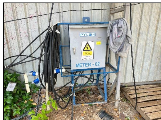
ภาพที่ 33 ตู้ควบคุมไฟฟ้า
