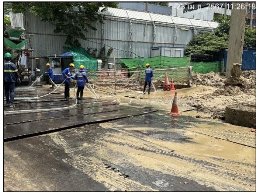
ภาพที่ 5 นีลพรมน้ำบริเวณพื้นที่ก่อสร้าง
