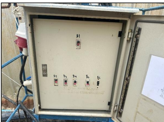
ภาพที่ 32 อุปกรณ์ตัดกระแสไฟฟ้า
