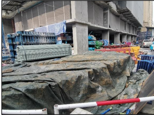
ภาพที่ 38 ผ้าใบปิดคลุมวัสดุก่อสร้าง
