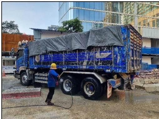
ภาพที่ 40 พื้นที่ล้างล้อรถบรรทุก
