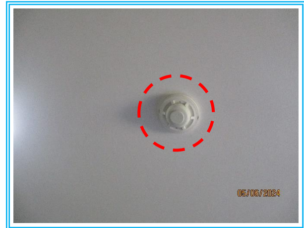
รูปที่ 3-58 เครื่องตรวจจับความร้อน
