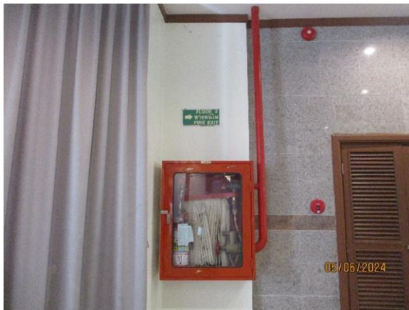
รูปที่ 3-51 ตู้เก็บอุปกรณ์ดับเพลิง
