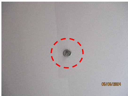
รูปที่ 2.6-5 หัวกระจายน้ำดับเพลิง
