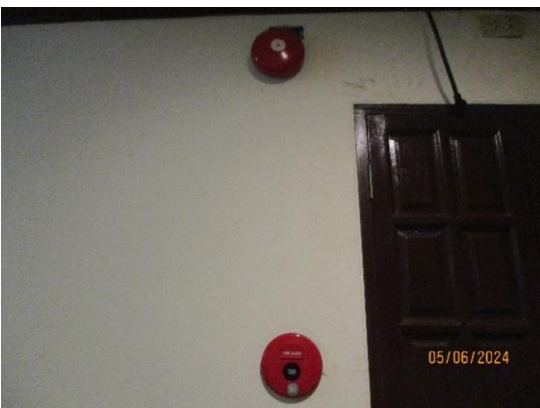
รูปที่ 2.6-4 สัญญาณเตือนภัยฉุกเฉิน
