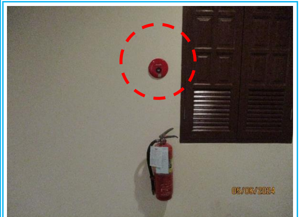
รูปที่ 3-54 อุปกรณ์แจ้งเหตุเพลิงไหม้ด้วยมือ
