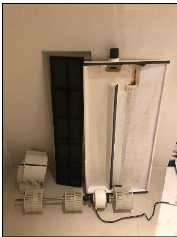
รูปที่ 2.2-11 การล้างทำความสะอาดเครื่องปรับอากาศ
