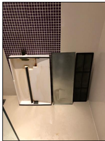
รูปที่ 2.2-11 การล้างทำความสะอาดเครื่องปรับอากาศ
