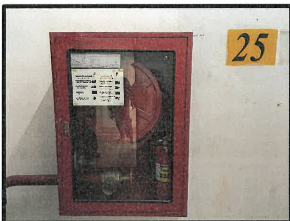
รูปที่ 3.19 ตู้เก็บสายฉีดน้ำดับเพลิงพร้อมอุปกรณ์ (FHC) และป้ายแนะนำการใช้อุปกรณ์
