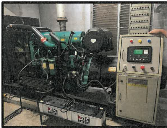
รูปที่ 3.17 เครื่องกำเนิดไฟฟ้าฉุกเฉิน
