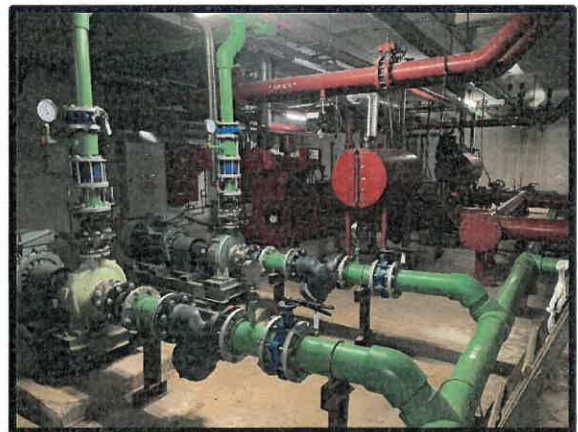
รูปที่ 3.18 เครื่องสูบน้ำดับเพลิง (Fire pump)
