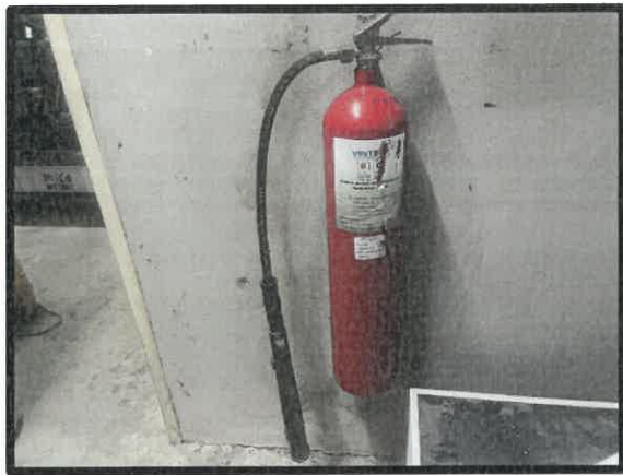
รูปที่ 3.20 ถังดับเพลิงเคมี ชนิด ABC
