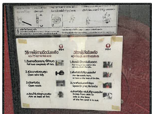
รูปที่ 3.19 ตู้เก็บสายฉีดน้ำดับเพลิงพร้อมอุปกรณ์ (FHC) และป้ายแนะนำการใช้อุปกรณ์
