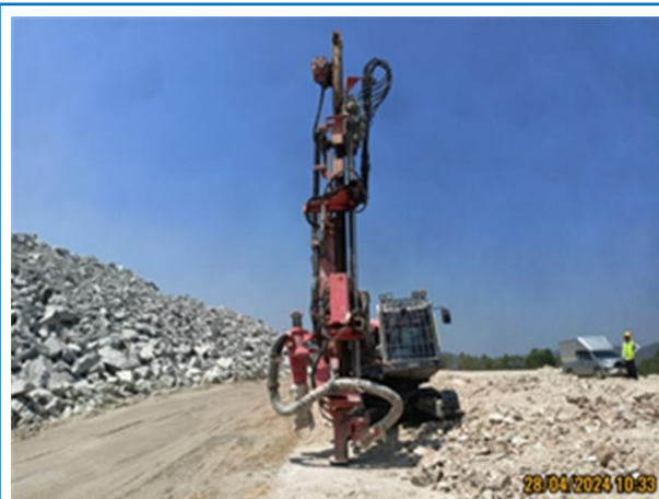
รูปที่ 3-11 เครื่องดูดฝุ่นบริเวณหัวเจาะระเบิด พร้อมทั้งถังพักฝุ่น
