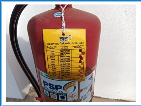
รูปที่ 3-26 ตรวจสอบอุปกรณ์ป้องกันอัคคีภัย
