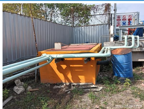
รูปที่ 3-14 ระบบรวบรวมน้ำปนเปื้อนน้ำมัน
