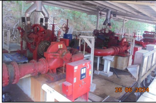
เครื่องยนต์ขับเคลื่อนน้ำดับเพลิงชนิดท่อน้ำทะเล
