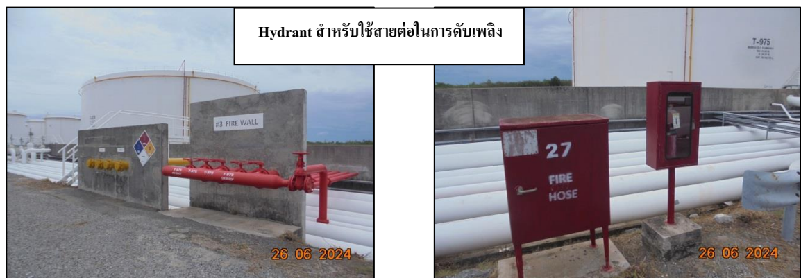
รูปที่ 9 ระบบดับเพลิงภายนอกอาคารใช้โฟมสำหรับดับเพลิง
