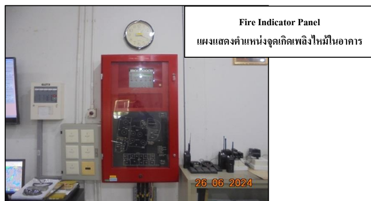
รูปที่ 11 ระบบแจ้งเตือน และระบบดับเพลิงภายในอาคาร
