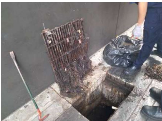
ภาพที่ 16 ทำความสะอาดท่อระบายน้ำ
