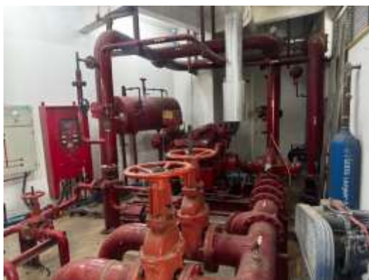
ภาพที่ 25 ระบบดับเพลิงอัตโนมัติ
