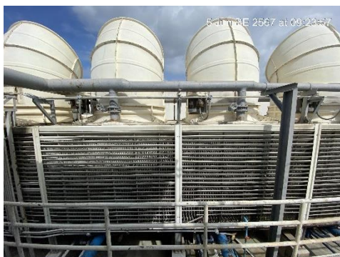
Cooling Tower หรือหอหล่อเย็น ภาพที่ 2.2-9 ระบบปรับอากาศและระบบระบายอากาศ
