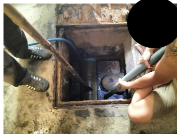
การสูบตะกอนระบบบำบัดน้ำเสีย
