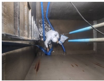
การล้างทำความสะอาดถังเก็บน้ำ
