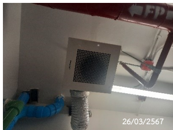
การระบายอากาศ และการระบายน้ำห้องพักมูลฝอยประจำชั้น
