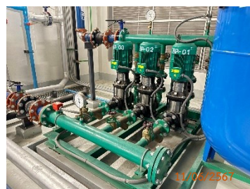
Booster Pump ชั้นดาดฟ้า
