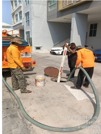
ภาพที่ 2.2-17 การสูบล้างระบบบำบัดน้ำเสีย
