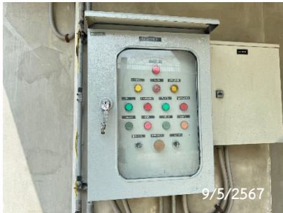
ตู้ควบคุมบ่อพักน้ำหน้าห้องพัก มุลฝอยรวม
