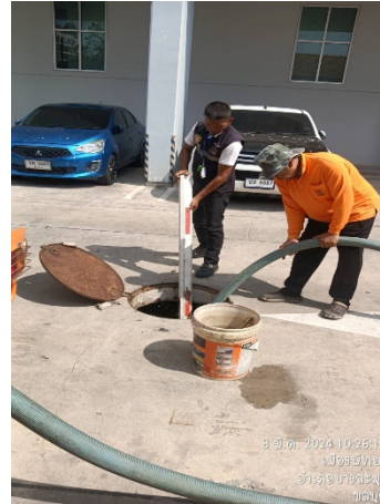
ภาพที่ 2.2-17 การสูบล้างระบบบำบัดน้ำเสีย
