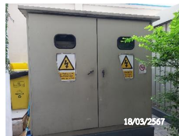
หม้อแปลงไฟฟ้าของการไฟฟ้านครหลวง
