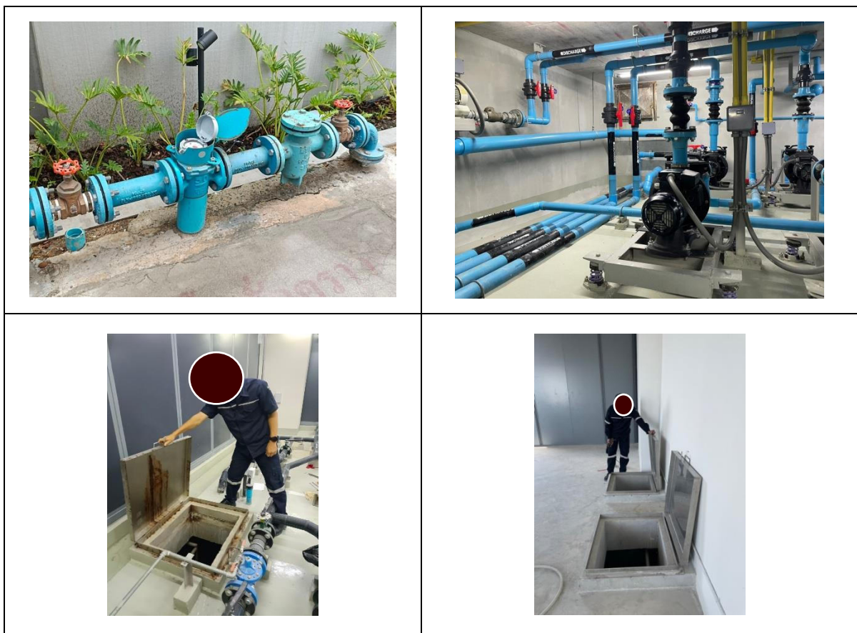
ภาพที่ 1.3.3-1 การสำรองน้ำและระบบการจ่ายน้ำประปา
