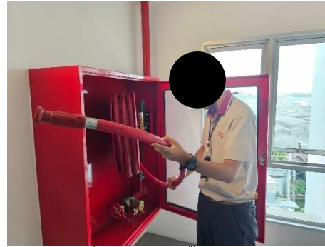
เจ้าหน้าที่ตรวจสอบสายฉีดน้ำดับเพลิง
