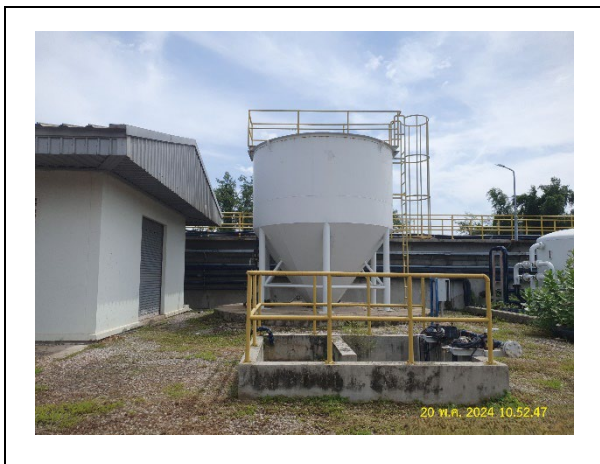
รูปถ่ายที่ 3.2-11 : ถังพักน้ำทิ้ง RO Reject
