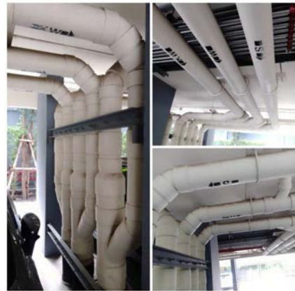
รูปที่ 2-34 ท่อรวมน้ำเสียของห้องพักรวม
