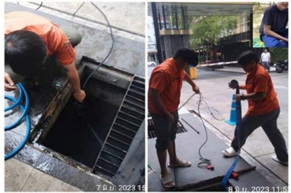
รูปที่ 2-11 การสูบลากตะกอน
