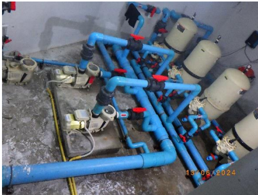
รูปที่ 63 ระบบกรองและระบบเกลือ (Salt Chlorinator) สำหรับสระว่ายน้ำ
