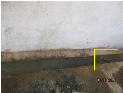
รูปที่ 40 ท่อรวบรวมน้ำจากห้องพักขยะรวม
