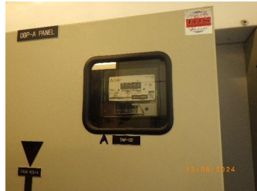
รูปที่ 41 ระบบมิเตอร์ไฟฟ้าสำหรับระบบบำบัดน้ำเสีย
