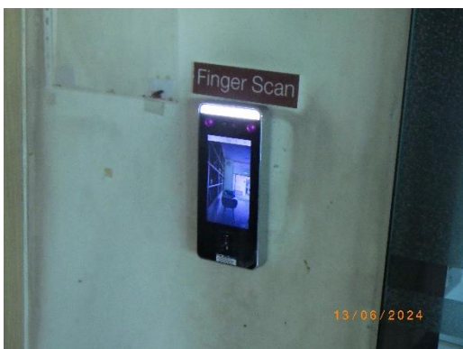
รูปที่ 44 ระบบสแกนนิ้วและหน้าบริเวณทางเข้าอาคาร
