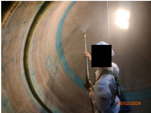
รูปที่ 69 การทำความสะอาดถังเก็บน้ำใช้
