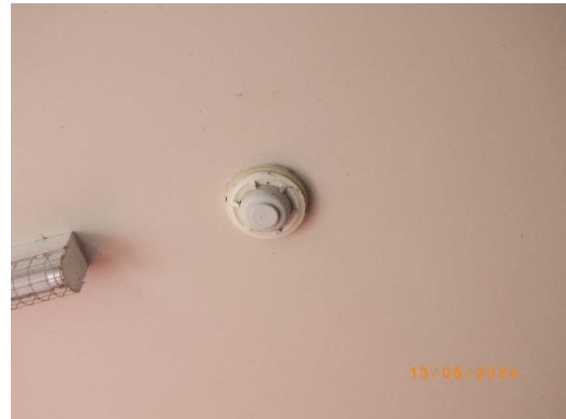
รูปที่ 4 เครื่องตรวจจับควัน
