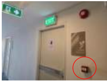
อุปกรณ์แจ้งเหตุเพลิงไหม้แบบใช้มือ
