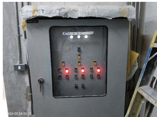
ตู้ควบคุมปั๊มสูบน้ำบ่อหน่วงน้ำ
