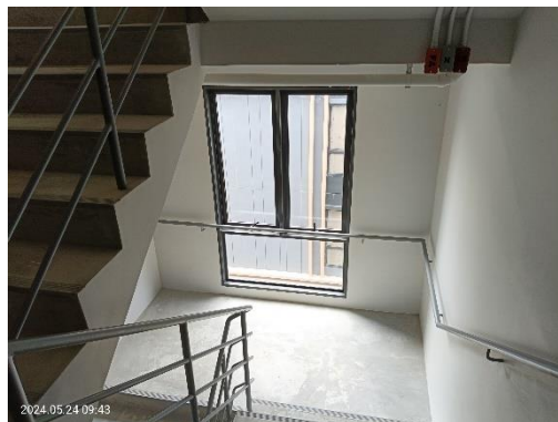
ช่องเปิดระบายอากาศบริเวณบันไดหนีไฟ
