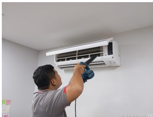
เจ้าหน้าที่ล้างทำความสะอาดเครื่องปรับอากาศส่วนกลาง
