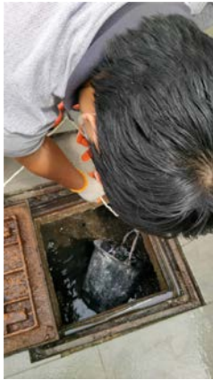
รูปที่ 2-14 การตัดกากไขมัน
