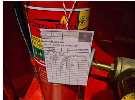
รูปที่ 2-83 ตรวจสอบถังดับเพลิง
