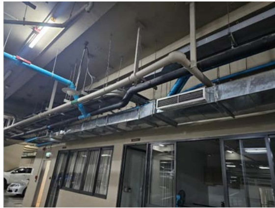
รูปที่ 2-6 ระบบระบายอากาศบริเวณลานจอดรถชั้นใต้ดิน
