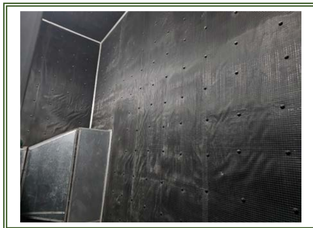
รูปที่ 2-51 ห้องเครื่องกำเนิดไฟฟ้าที่มีผนังกันเสียง
