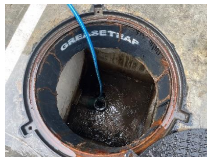
ภาพที่ 2.2-20 การสูบน้ำจากระบบบำบัดน้ำเสีย
