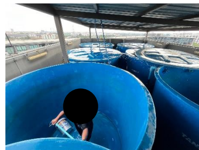
ภาพที่ 2.2-19 การล้างถังเก็บน้ำใช้
