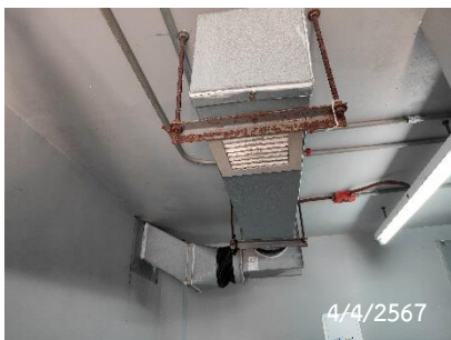
พัดลมระบายอากาศห้องเก็บสารเคมี
