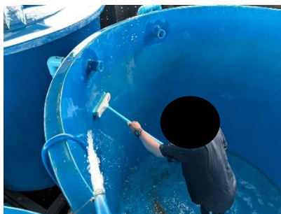
ภาพที่ 2.2-19 การล้างถังเก็บน้ำใช้
