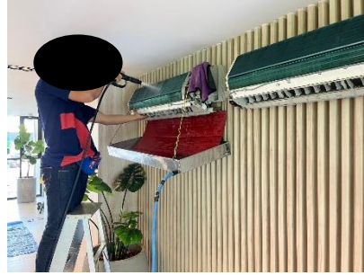
ภาพที่ 2.2-22 การล้างเครื่องปรับอากาศ
