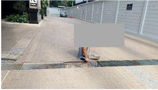
รูปที่ 2-54 เจ้าหน้าที่ชุดลอกทำความสะอาดรางระบายน้ำของโครงการ
