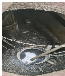
ดูแล ตรวจสอบระบบบำบัดน้ำเสีย โดยตักไขมัน และสูบกากตะกอนจากบ่อบำบัดน้ำเสียเป็นประจำสม่ำเสมอ
