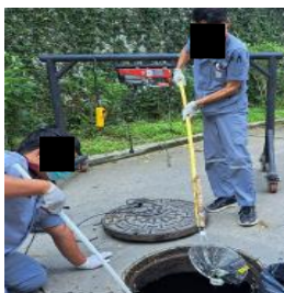
ดูแล ตรวจสอบระบบบำบัดน้ำเสีย โดยตักไขมัน และสูบกากตะกอนจากบ่อบำบัดน้ำเสียเป็นประจำสม่ำเสมอ
