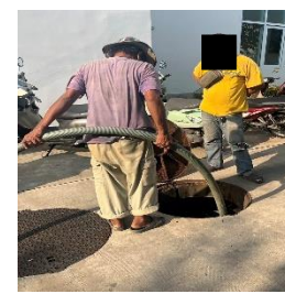
ดูแล ตรวจสอบระบบบำบัดน้ำเสีย โดยตักไขมัน และสูบกากตะกอนจากบ่อบำบัดน้ำเสียเป็นประจำสม่ำเสมอ
