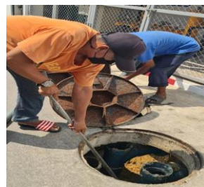
ดูแล ตรวจสอบระบบบำบัดน้ำเสีย โดยตักไขมัน และสูบกากตะกอนจากบ่อบำบัดน้ำเสียเป็นประจำสม่ำเสมอ
