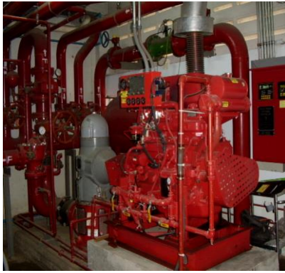
เครื่องสูบน้ำดับเพลิง
