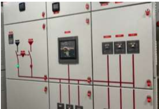
Main Distribution Board : MDB และ Circuit Breaker : CB
