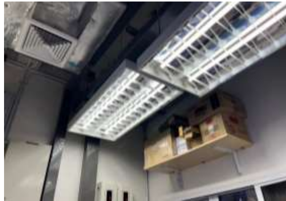
เลือกใช้โคมไฟสะท้อนแสง และหลอด LED
