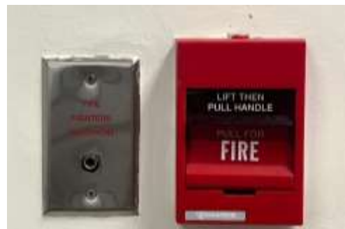
Telephone Jack และ Manual Station
