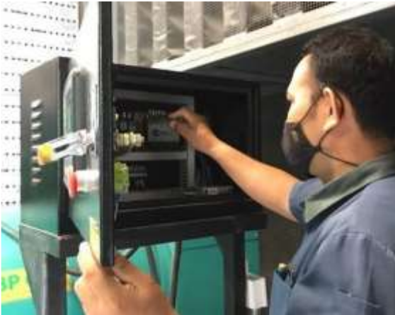
ตรวจสอบเครื่องกำเนิดไฟฟ้า
