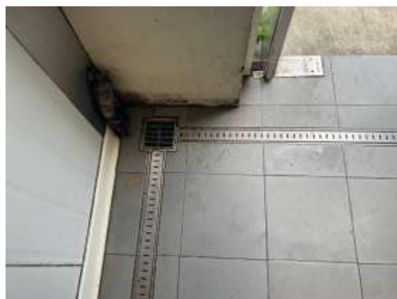
ท่อรับน้ำจากห้องพักรวไรโซเคิลไปยังระบบบำบัดน้ำเสีย
