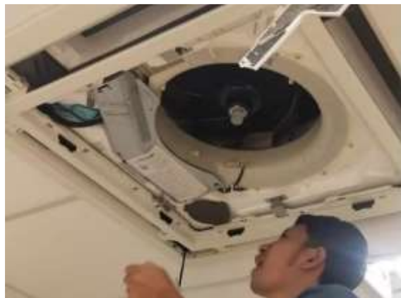
ภาพที่ 2-23 เจ้าหน้าที่ล้างทำความสะอาดเครื่องปรับอากาศ
