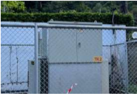
หม้อแปลงไฟฟ้า TR 1-2
