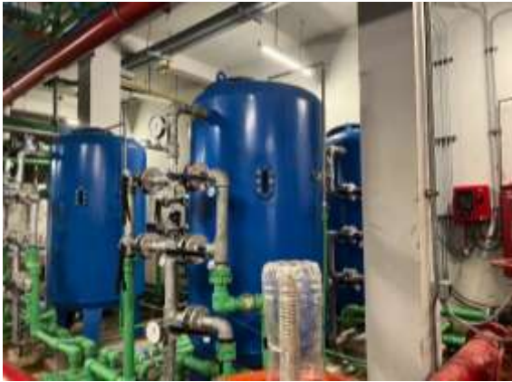
ระบบนำน้ำทิ้งที่ผ่านการบำบัดมารดน้ำต้นไม้
