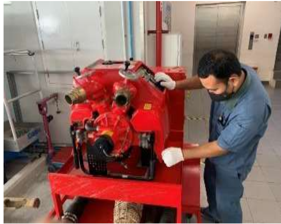
ตรวจสอบปั๊มสูบน้ำสำรอง
