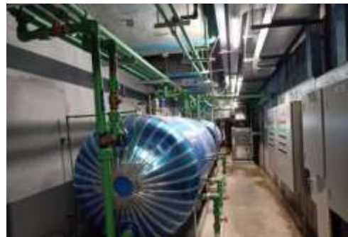
เครื่องทำน้ำร้อนแบบ Heat pump
