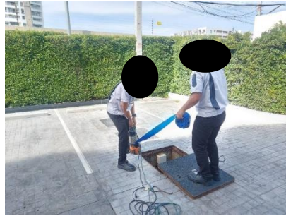
ภาพที่ 2.2-23 การสูบน้ำออกจากระบบบำบัดน้ำเสีย
