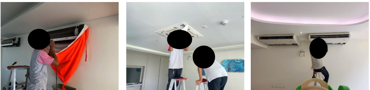
ภาพที่ 2.2-21 การล้างทำความสะอาดเครื่องปรับอากาศ
