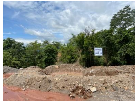
รูปที่ 2-9(ต่อ) ตัวอย่างบ่อดักตะกอน บ่อ 9 และ 10 ในโครงการ
