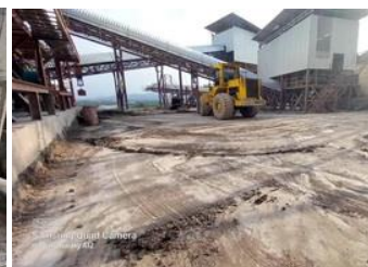
รูปที่ 2-23ก. โรงโม่หินที่เป็นระบบปิด และมีการติดตั้งระบบสเปรย์น้ำ
