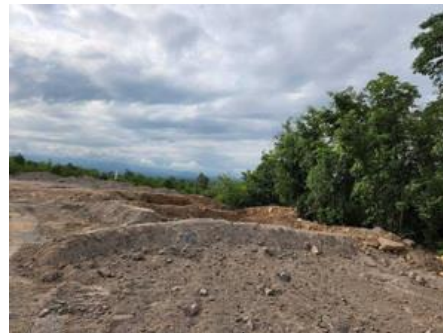
รูปที่ 2-24ค. บ่อดักเก็บกักน้ำเพื่อให้มีการตกตะกอน ป้องกันการชะล้างตะกอนดินออกสู่ภายนอกโดยตรง
