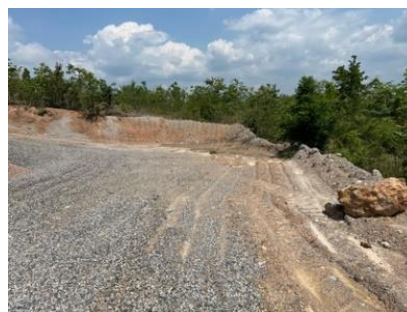
รูปที่ 2-6 คั่นทำนบดิน ร่องระบายน้ำบริเวณจุดเก็บกองเปลือกดิน และเศษหินชั่วคราว
