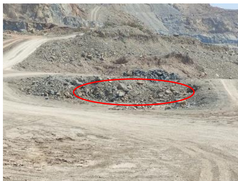
รูปที่ 2-10 จุดที่เป็นพื้นที่ต่ำที่ใช้เป็นพื้นที่รองรับปริมาณน้ำไหลบ่าจากพื้นที่หน้าเหมือง
