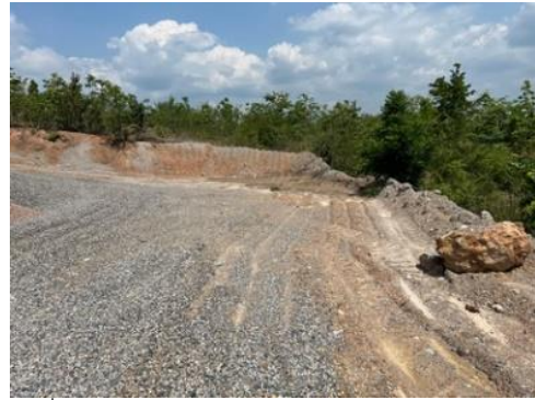
รูปที่ 2-24ก. คั่นทำนบดินรอบโรงโม่และจุดกองดิน
