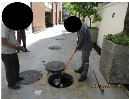
จุดเก็บน้ำเสียก่อนเข้าระบบบำบัดน้ำเสีย
