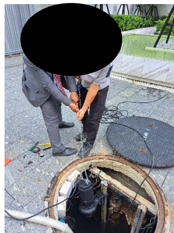
ภาพที่ 2.2-15 การตรวจเช็คปั๊มบ่อบำบัดน้ำเสีย
