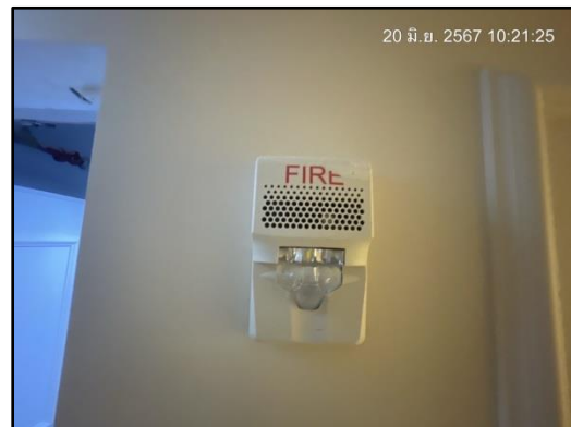
รูปที่ 51 อุปกรณ์เตือนภัยแบบใช้แสงและเสียง
