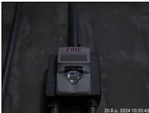
รูปที่ 51 อุปกรณ์เตือนภัยแบบใช้แสงและเสียง
