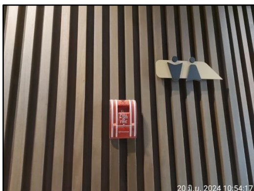
รูปที่ 50 อุปกรณ์เตือนภัยแบบใช้มือดึง
