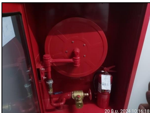
รูปที่ 48 ตู้เก็บสายฉีดดับเพลิง
