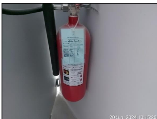
รูปที่ 49 ถังดับเพลิงแบบมือถือ
