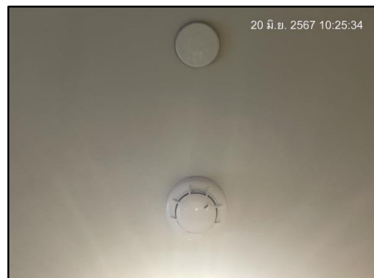
รูปที่ 51 อุปกรณ์เตือนภัยแบบใช้แสงและเสียง
