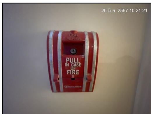
รูปที่ 50 อุปกรณ์เตือนภัยแบบใช้มือดึง
