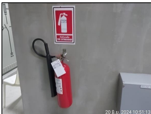
รูปที่ 49 (ต่อ) ถังดับเพลิงแบบมือถือ
