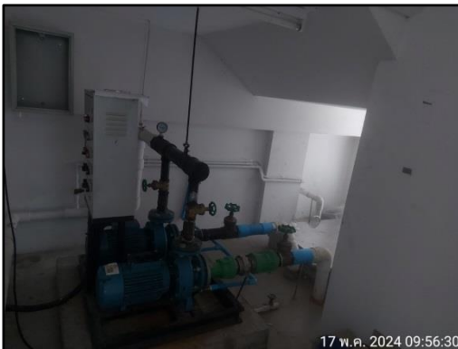
รูปที่ 17 ปั๊มถังเก็บน้ำชั้นใต้ดิน
