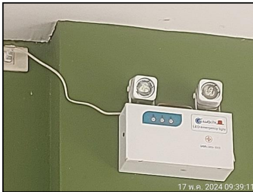
รูปที่ 33 ไฟส่องสว่างฉุกเฉิน
