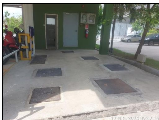
รูปที่ 9 ระบบบำบัดน้ำเสียและตู้ควบคุมระบบบำบัดน้ำเสีย
