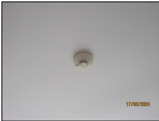
รูปที่ 28 เครื่องตรวจจับควัน
