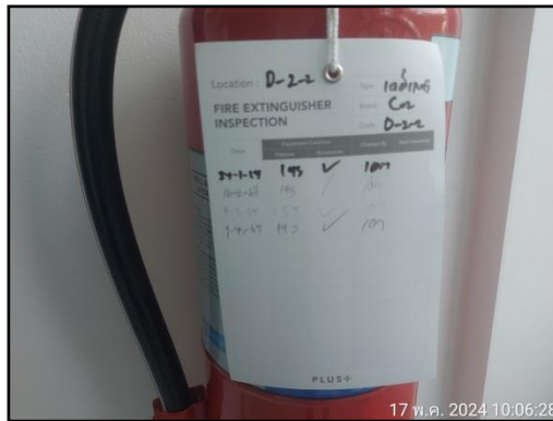
รูปที่ 35 ตรวจเช็คถังดับเพลิง
