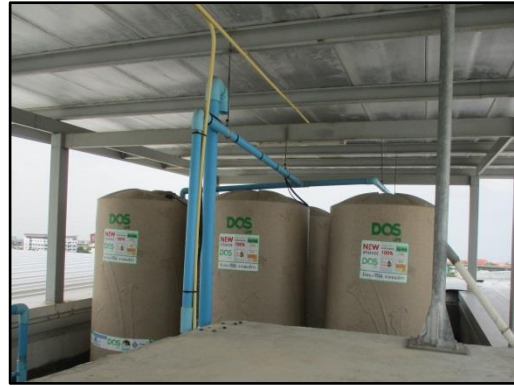
รูปที่ 16 (ต่อ) ถังเก็บน้ำชั้นดาดฟ้า
