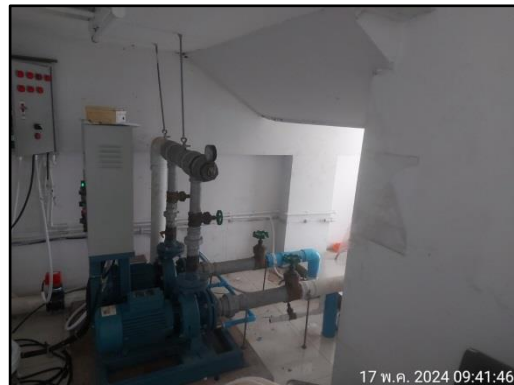
รูปที่ 17 ปั๊มถังเก็บน้ำชั้นใต้ดิน
