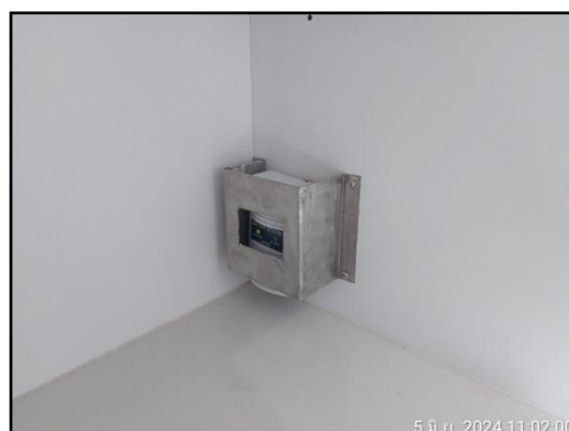
รูปที่ 49 Gas Leak Detector
