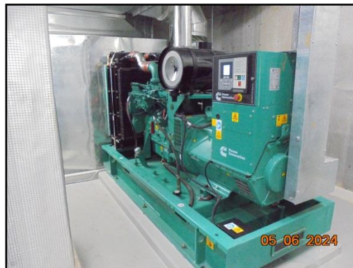
รูปที่ 53 ระบบไฟฟ้าสำรองของโครงการ
