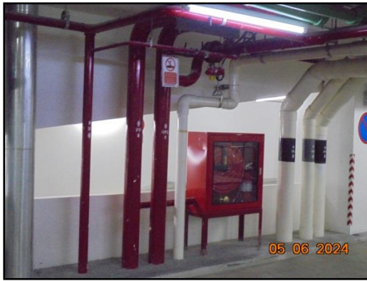
รูปที่ 52 (ต่อ) ระบบท่อขึ้น หัวรับจ่ายน้ำดับเพลิง และตู้เก็บสายฉีดน้ำดับเพลิง
