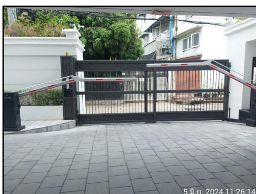
รูปที่ 13 ระบบเซนส์กันรถยนต์ควบคุมการเข้าออกของรถ
