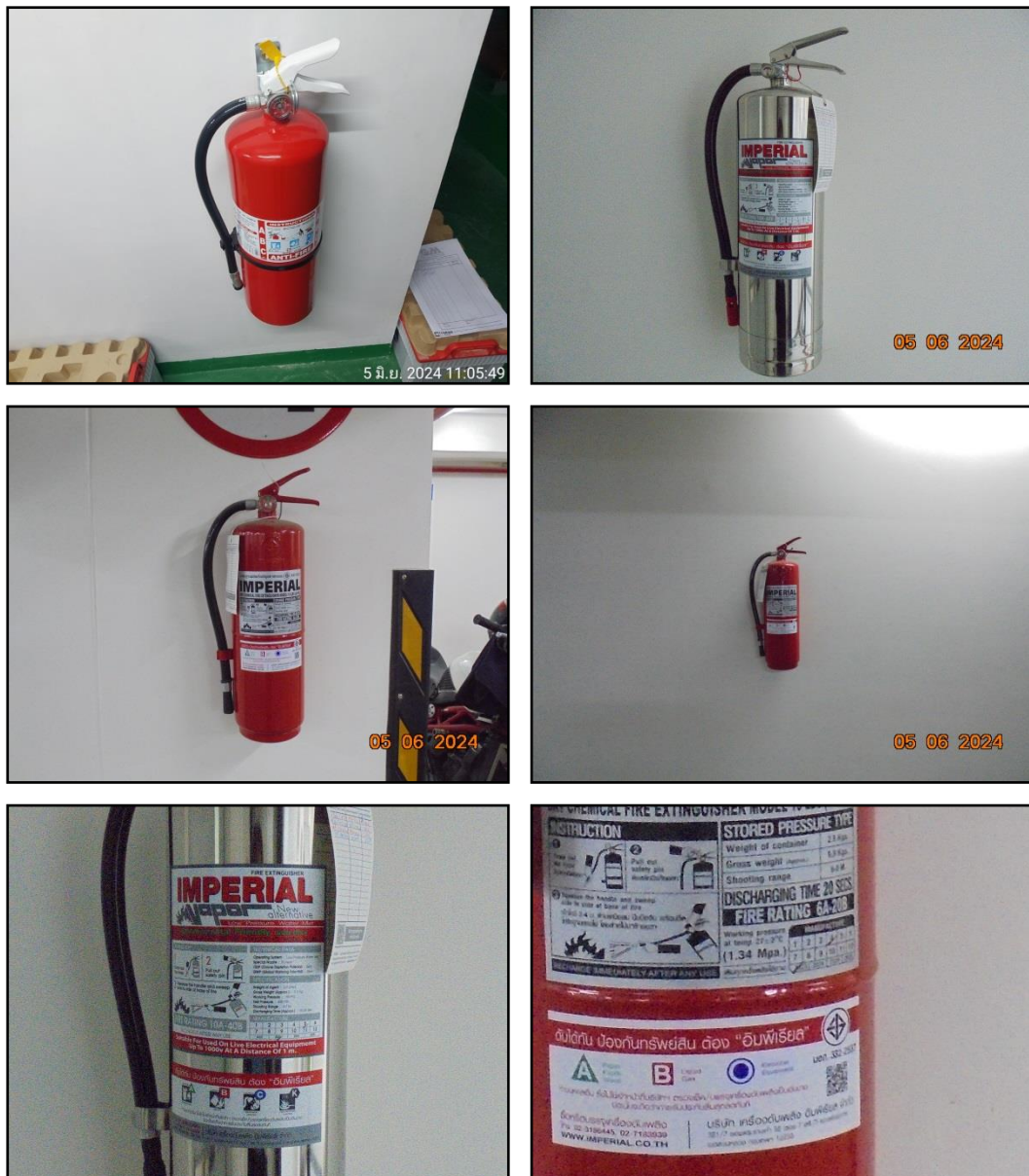
รูปที่ 50 ถังดับเพลิงแบบมือถือ และวิธีแนะนำการใช้อุปกรณ์
