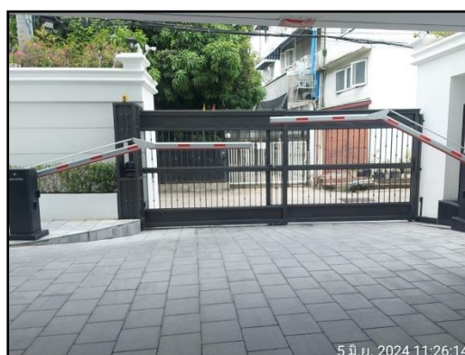
รูปที่ 13 ระบบเซนส์กันรถยนต์ควบคุมการเข้าออกของรถ
