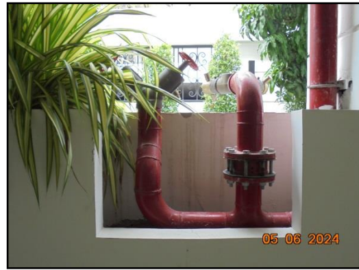
รูปที่ 52 (ต่อ) ระบบท่อขึ้น หัวรับจ่ายน้ำดับเพลิง และตู้เก็บสายฉีดน้ำดับเพลิง
