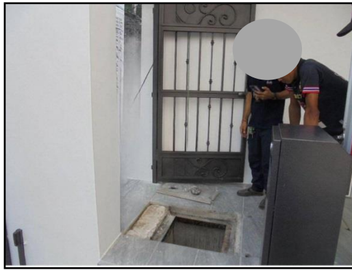
รูปที่ 35 ตรวจเช็คขยะ /ตะกอนบริเวณท่อระบายน้ำท่อและบ่อพักน้ำ
