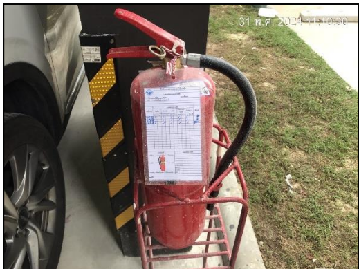
ภาพที่ 32 ถังดับเพลิงและการตรวจสอบ
