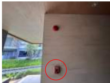
รูปที่ 2-39 เครื่องแจ้งเหตุโดยใช่มือดึง (Fire Alarm Manual Station)
