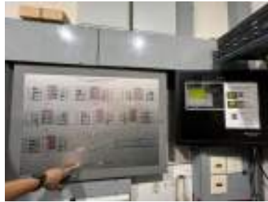
รูปที่ 2-36 แผงควบคุม (Fire Alarm Control Panel: FCP)
