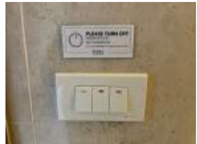
รูปที่ 2-31 แยกสวิตช์ควบคุมอุปกรณ์ไฟฟ้าแสงสว่าง
