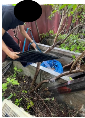
ภาพที่ 2.2-23 การล้างทำความสะอาดเครื่องปรับอากาศ
