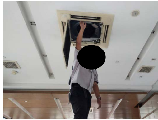
ภาพที่ 2.2-23 การล้างทำความสะอาดเครื่องปรับอากาศ
