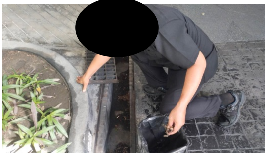
ภาพที่ 2.2-28 การตัดต้นไม้/เศษขยะออกจากระบบระบายน้ำ
