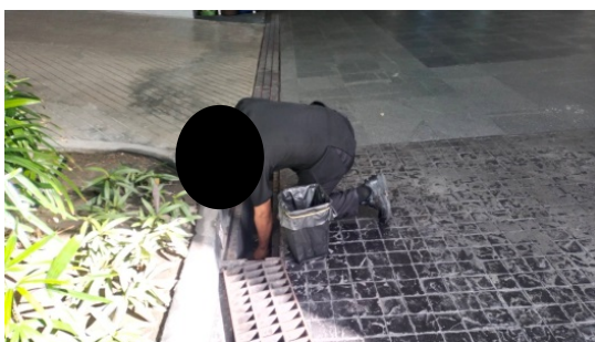
ภาพที่ 2.2-28 การตัดต้นไม้/เศษขยะออกจากระบบระบายน้ำ
