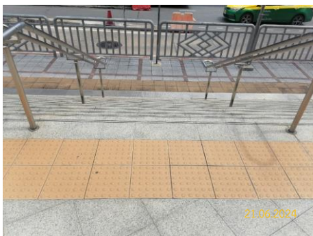
ภาพที่ 2.2-27 กระเบื้องปูพื้นพิเศษบอกพื้นต่างระดับสำหรับผู้พิการทางสายตา
