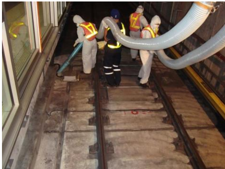
ภาพที่ 2.2-1 การดูดฝุ่นอุโมงค์ และการสวมใส่อุปกรณ์ป้องกันขณะปฏิบัติงาน
