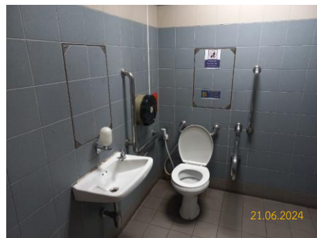
ภาพที่ 2.2-30 ห้องน้ำสำหรับผู้พิการซึ่งอุปกรณ์จะอยู่ไม่สูง
