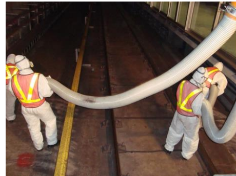
ภาพที่ 2.2-1 การดูดฝุ่นอุโมงค์ และการสวมใส่อุปกรณ์ป้องกันขณะปฏิบัติงาน
