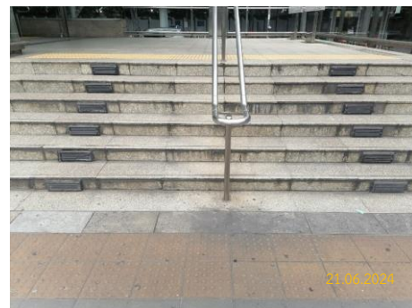
ภาพที่ 2.2-27 กระเบื้องปูพื้นพิเศษบอกพื้นต่างระดับสำหรับผู้พิการทางสายตา
