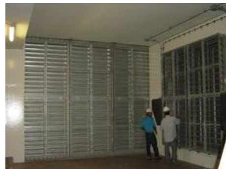
ภาพที่ 2.2-6 ปล่องระบายอากาศจากใต้ชั้นชานชาลาสู่ภายนอก
