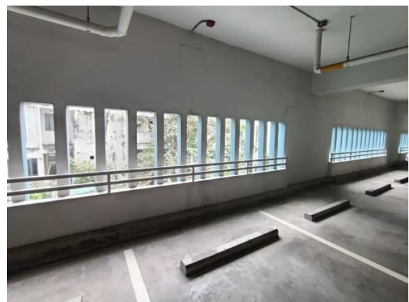
รูปที่ 2-14 มีการออกแบบให้ชั้นลานจอดรถมีช่องที่สามารถระบายอากาศได้สะดวก
