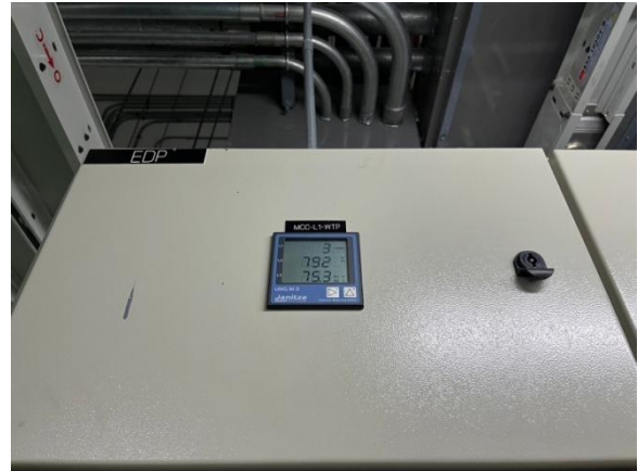
รูปที่ 2-19 ระบบมิเตอร์ไฟฟ้าสำหรับระบบบำบัดน้ำเสีย
