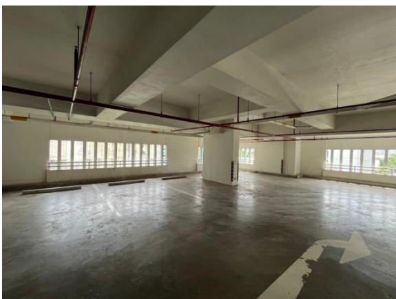
รูปที่ 2-14 มีการออกแบบให้ชั้นลานจอดรถมีช่องที่สามารถระบายอากาศได้สะดวก
