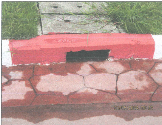
ภาพที่ 2.2-12 ตะแกรงดักขยะบริเวณท่อระบายน้ำ
