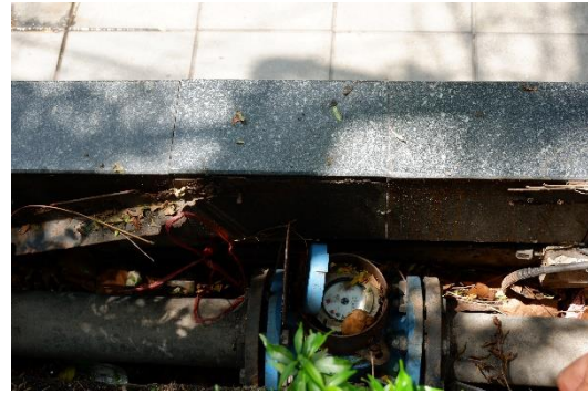
ภาพที่ 2-15 มิเตอร์น้ำประปาภายในโครงการ
