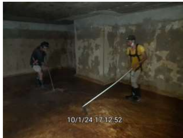
บ่อเก็บน้ำใต้ดิน 2 (Underground Tank 1) ขนาด 254 ลบ.ม.
