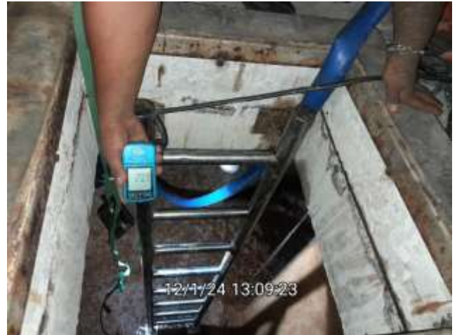
บ่อเก็บน้ำดับเพลิง 1 (Fire Water Tank 1) ขนาด 144 ลบ.ม.
